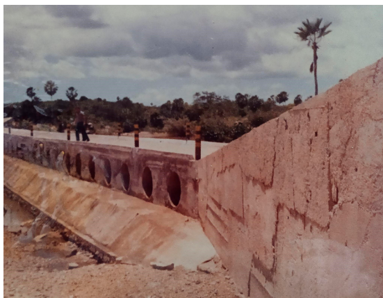
Figura 44 - Ponte sobre o Rio Pesqueiro. 1990. Camocim-CE
