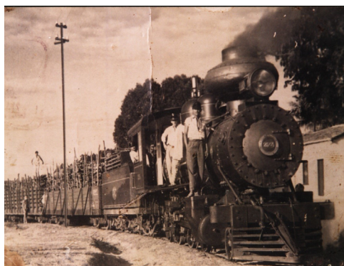
Figura 5 - Carregamento de madeira (Ipu-CE)
