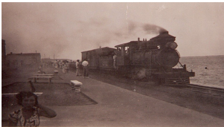
Figura 3 - Trem voltando para a Estação
