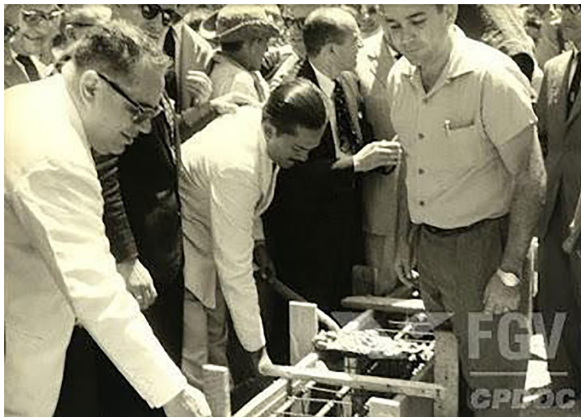
Ministro da Obras e Viação Pública, Ernani Peixoto do Amaral (primeiro da esquerda para a direita, de óculos e terno branco). Solenidade de lançamento da pedra fundamental do Cais do Porto de Camocim (setembro de 1959).
